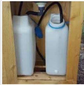
Achten Sie darauf, dass der Frischwasserschlauch bis unten in den Kanister geht - er wird sonst das Wasser unterhalb nicht fördern können.
